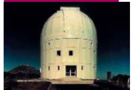
Estación Óptica Terrestre
