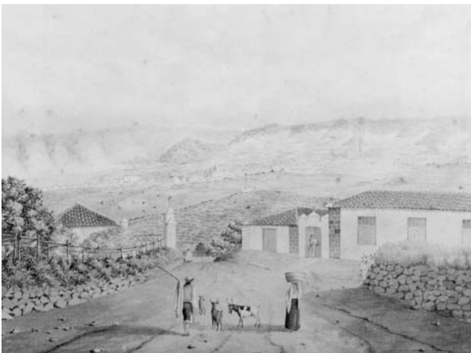
Fig. 4. Vista de La Orotava, desde cerca de la Casa Quemada. Acuarela de Alfred Diston (siglo XIX).
